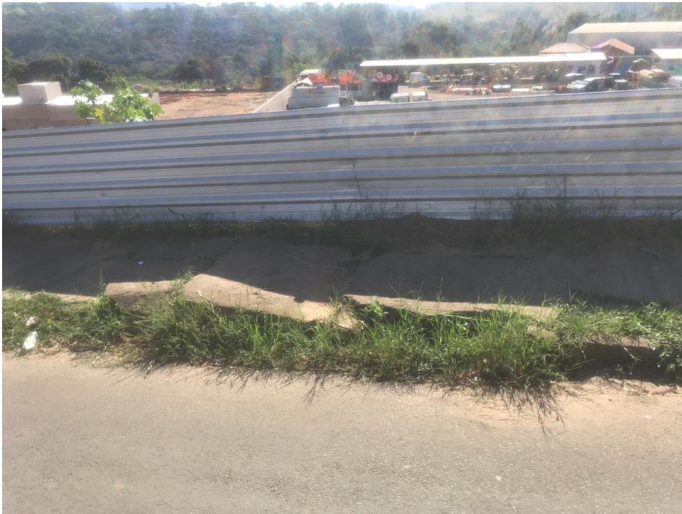
Figura 4 - Roçagem das calçadas do centro olímpico
