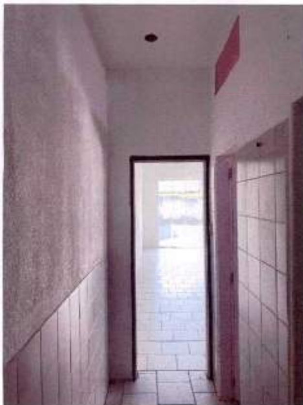
Imagem 19 – Corredor acesso aos banheiros e aos outros cômodos;
