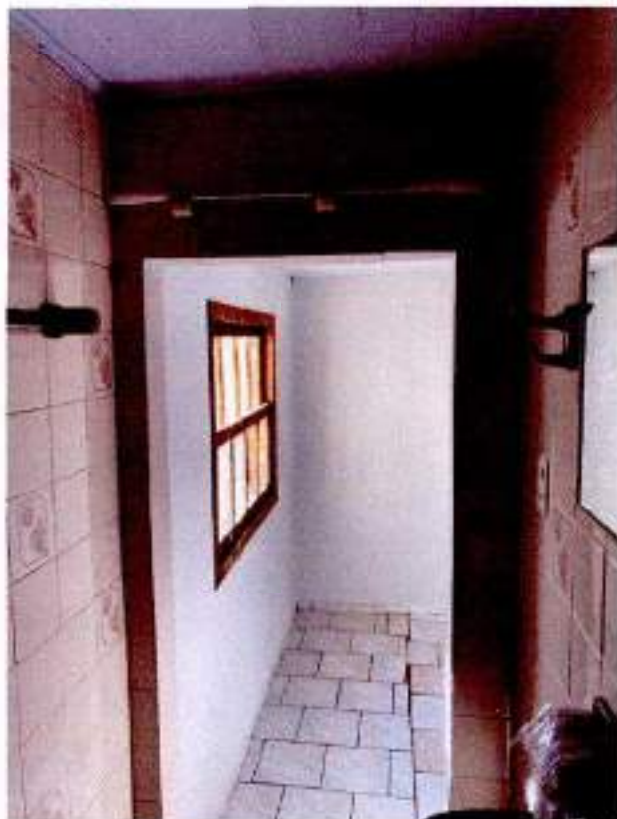
Imagem 41 – Banheiro do pavimento superior (Sala 1);
