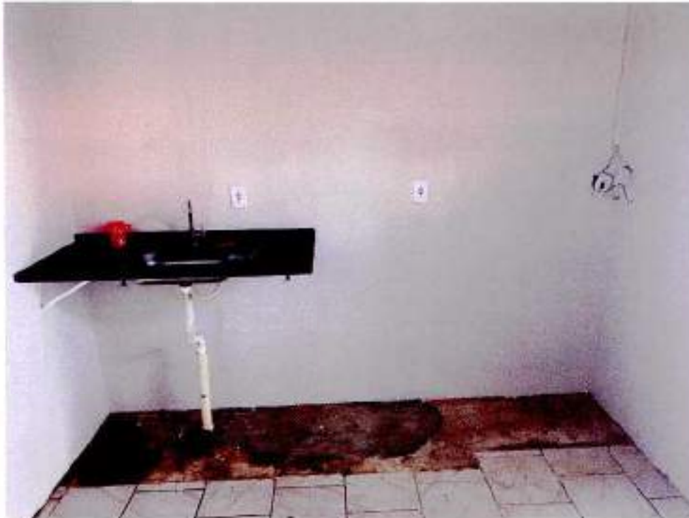
Imagem 10 - Piso da copa;
