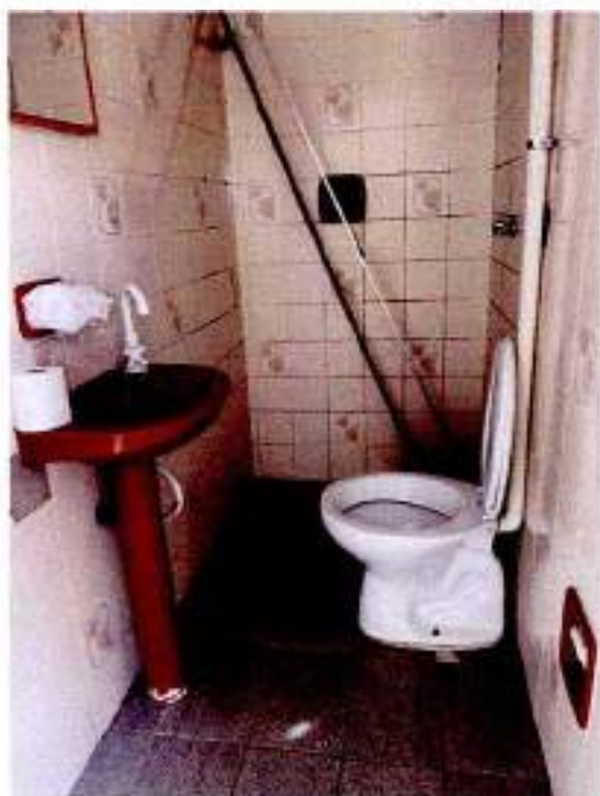
Imagem 42 – Banheiro do pavimento superior (Sala 1);
